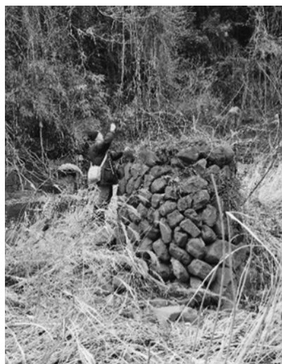
第4図 鉱山で使用された橋脚の一部
